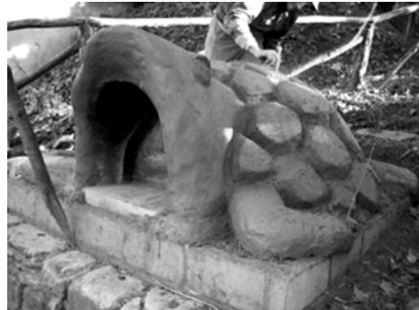
Forni in terra cruda realizzati dall'autore dell'articolo.
