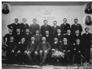
I fondatori dell'acquedotto di Montaldo.
