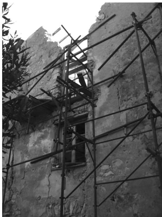
Cantiere a Ca' Favale (levante ligure): una delle realtà rurali in cui ha operato la Maknovicina.
